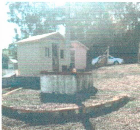
Figura 1- Local de demolição para execução do Altar
