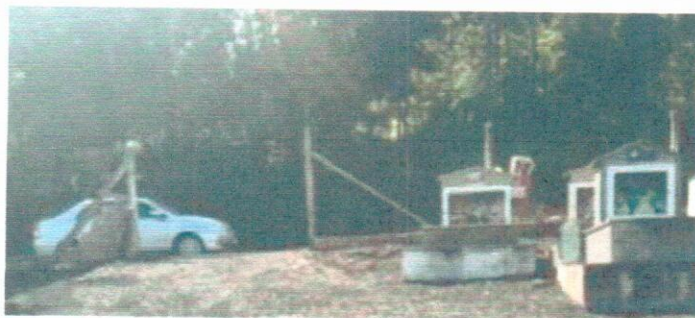
Figura 5- Local de demolição para execução de novas cercas e mureta
