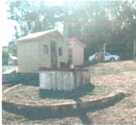
Figura 1- Local de demolição para execução do Altar
