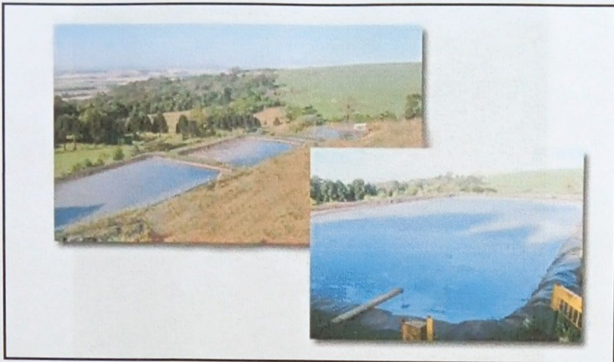
Figura 13: A terra Sanitário da Empresa Continental - Sistema de Tratamento de líquidos e percolados.
