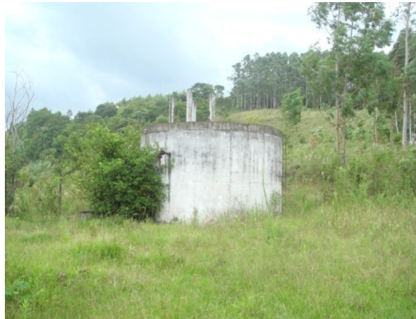
Figura 8.6 – Reservatório “C” concreto armado de 70m 3
