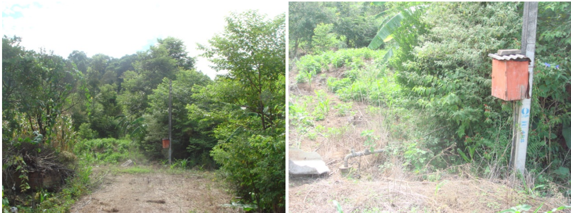
Figura 8.19 – Poço profundo – linha Sete de Setembro
