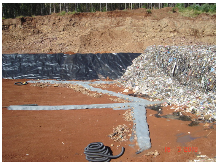
Figura 10.11 -Aterro Sanitário da CONTINENTAL-Xanxerê/SC – Sistema de Drenagem
