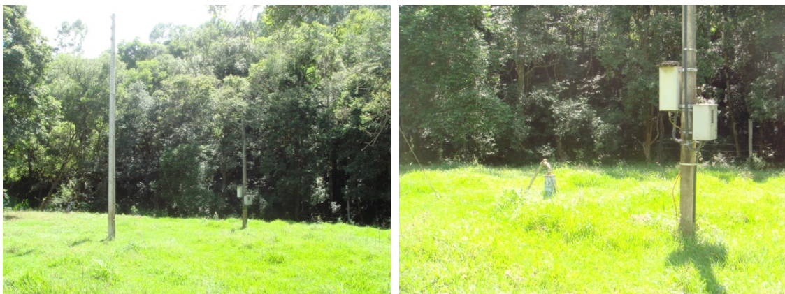
Figura 8.23 – Poço profundo – linha Quatro
