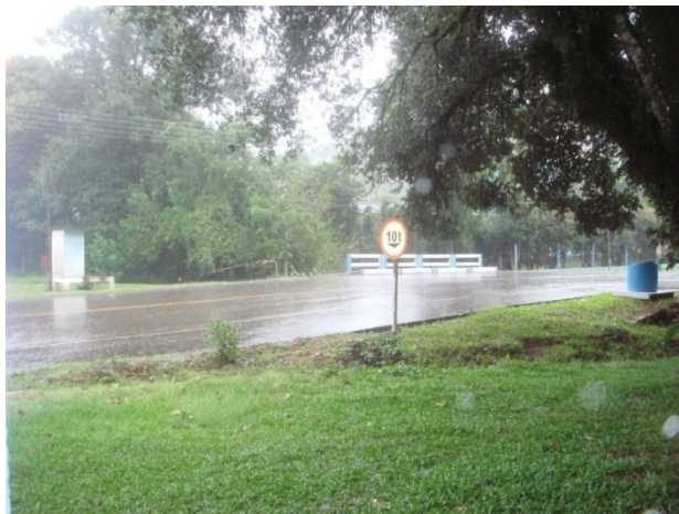
Figura 9.5 – Ponto de inundação – Próximo à praça
