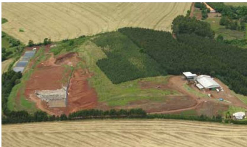
Figura 10.10 -Aterro Sanitário da empresa CONTINENTAL na cidade de Xanxerê – SC
