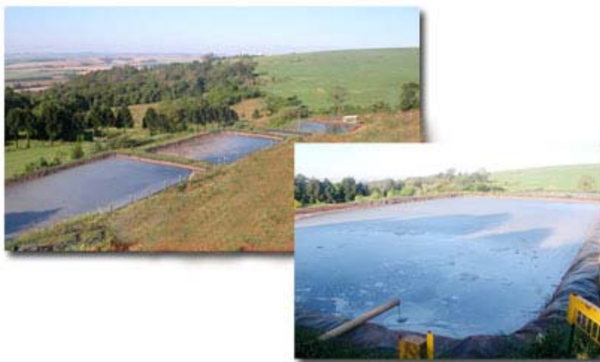
Figura 10.12 e 10.13 -Aterro Sanitário da empresa CONTINENTAL na cidade de Xanxere – SC – Sistema de Tratamento dos líquidos percolados
