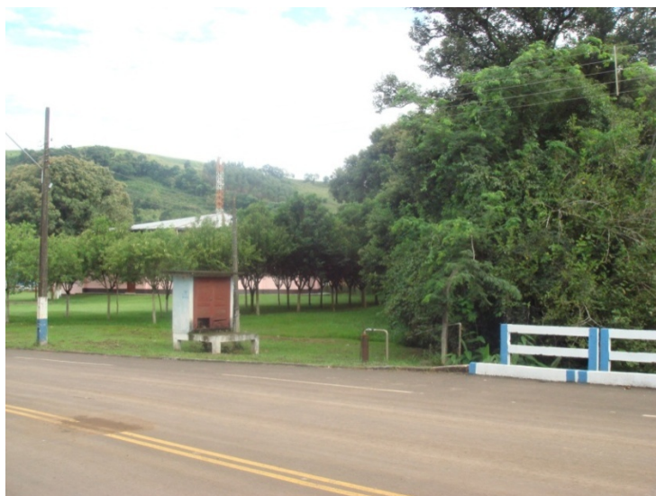
Figura 8.2 - Poço Profundo “A”
