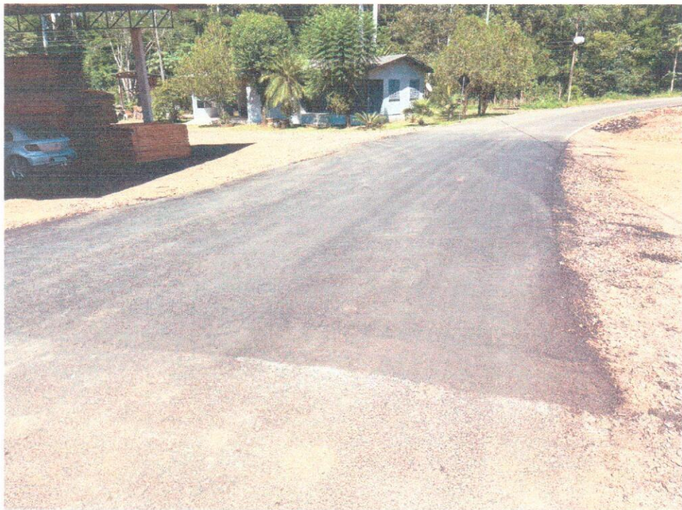
Reparo devido a danos causados por enchente
