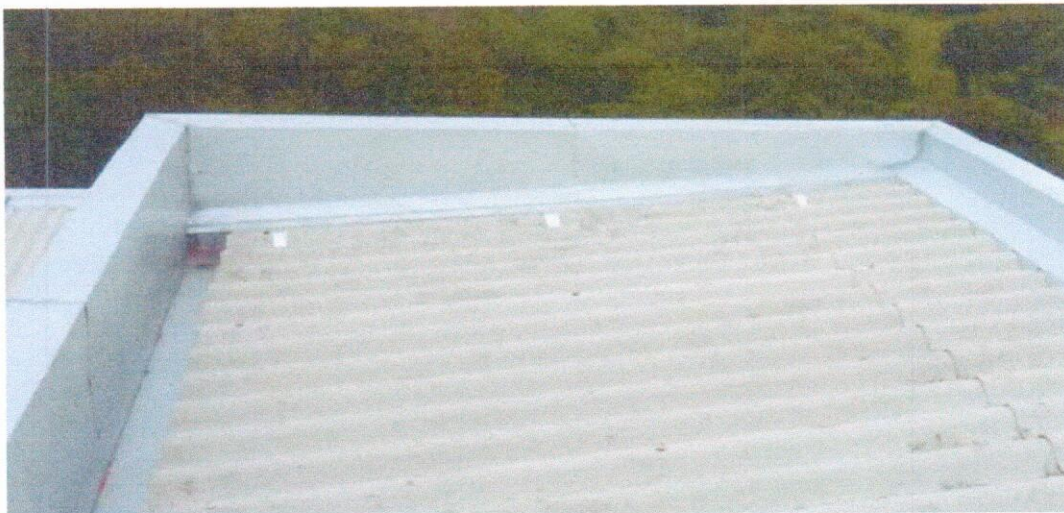
IMAGEM 2 – Modelo instalação de rufos e algerosas
