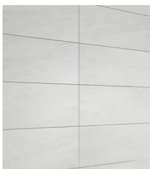
Figura 6-Cerâmicas das paredes
