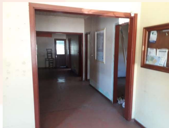
Figura 4 – Paredes interna a ser removidas.
