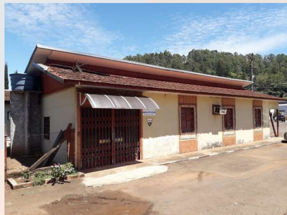
Figura 2 - Janelas e porta a serem removidas.
