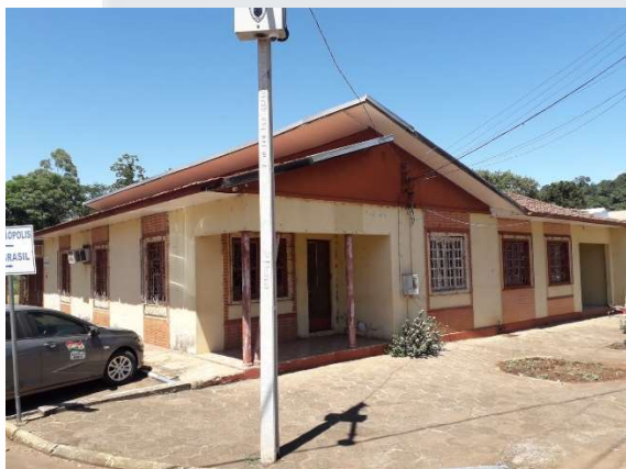
Figura 1 – Janelas, portas a serem removidas.
