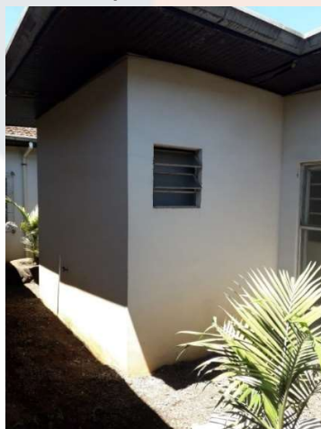
Figura 3 - Banheiros a ser removida.
