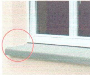
Figura 3. Peitoril embutido na alvenaria em 1 cm.
