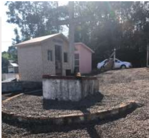
Figura 1- Local de demolição para execução do Altar
