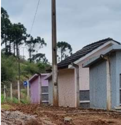
Figura 4- Local de demolição para execução de novas cercas
